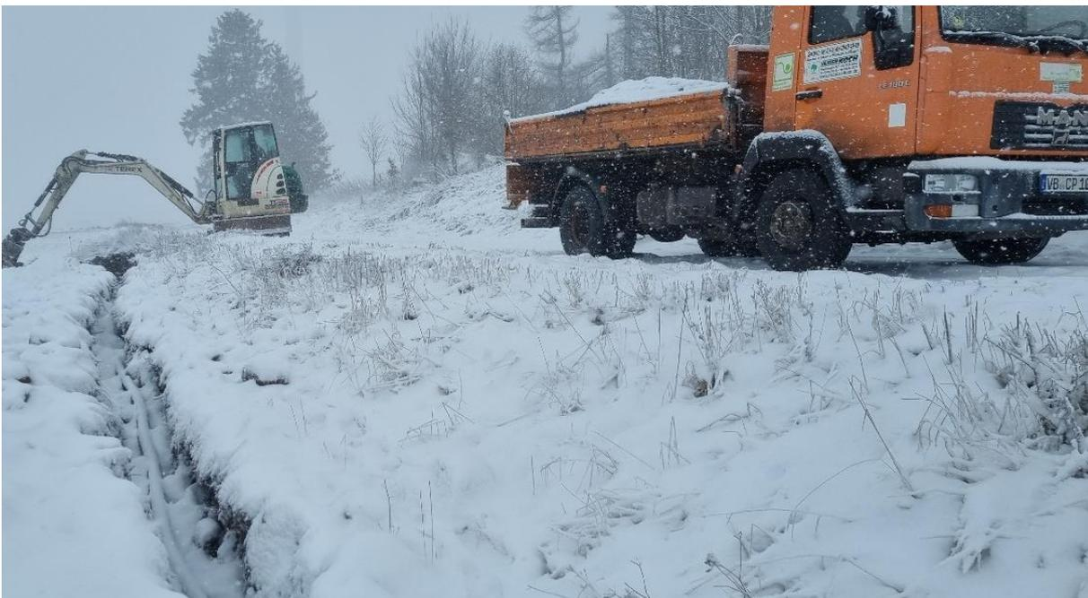
**Abbildung 11: Schließen des Kabelgrabens zwischen beiden IDF Standorten**
