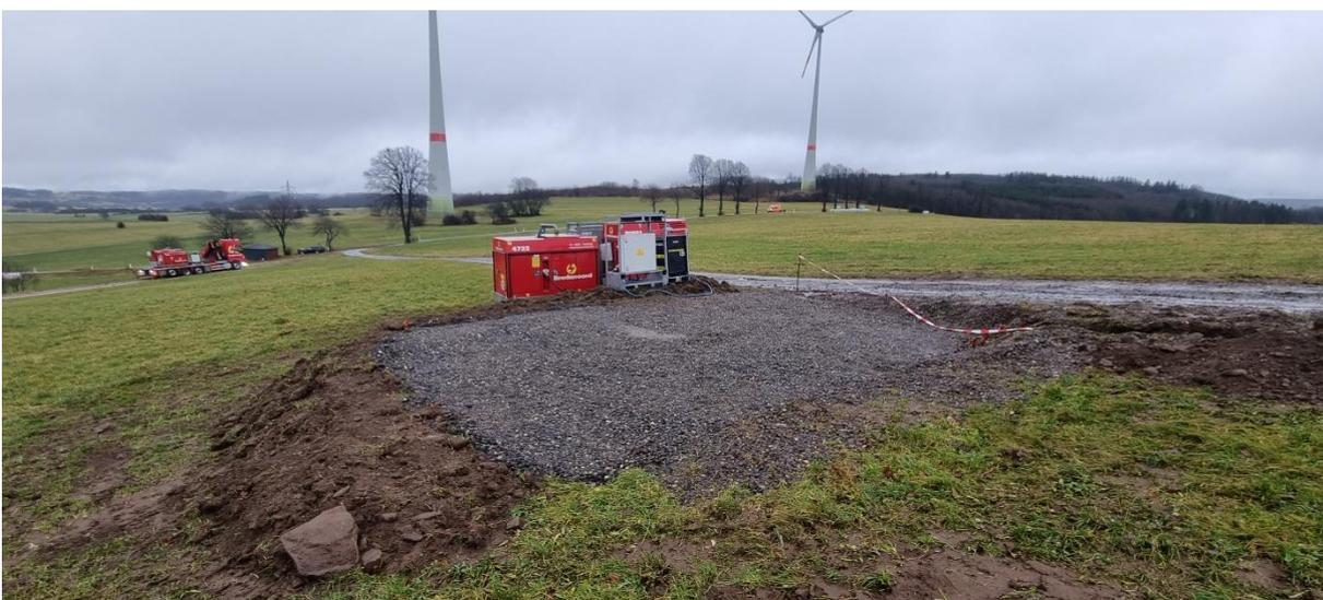
**Abbildung 9: Anlieferung und Aufbau der Stromversorgung am Standort IDF-1, im Vordergrund die temporär geschotterte Standfläche (154 m<sup>2</sup>)**
